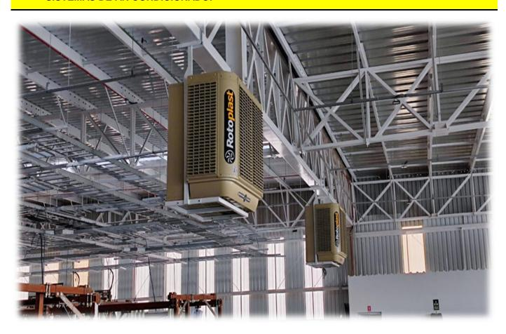
Sistemas de ventilação e insuflação de ar em ambientes de trabalho são projetados para promover a circulação do ar, remover o ar viciado e fornecer ar fresco, contribuindo para um ambiente mais saudável e confortável. Embora não "reduzam" a temperatura ambiente diretamente como um ar condicionado, eles desempenham um papel importante na gestão do calor e na sensação de conforto térmico.
