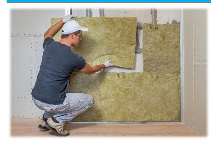
O isolamento térmico em paredes e tetos é uma estratégia eficaz para reduzir a transferência de calor entre o exterior e o interior de um ambiente, contribuindo para o conforto térmico e a economia de energia. Embora não "reduza" a temperatura ambiente diretamente como um ar condicionado, ele atua como uma barreira que dificulta a entrada do calor no verão e a saída do calor no inverno.
