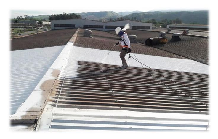
A estimativa de redução de calor ambiente com pintura no telhado varia bastante, dependendo de diversos fatores. No entanto, estudos indicam que é possível obter uma diminuição significativa na temperatura interna dos ambientes.
